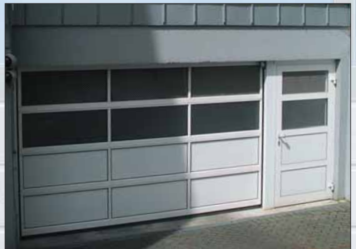
Sectionaaldeur met zijdeur, ISO platen gecombineerd met strekmetaal in ondergrondse parkeergarage.
